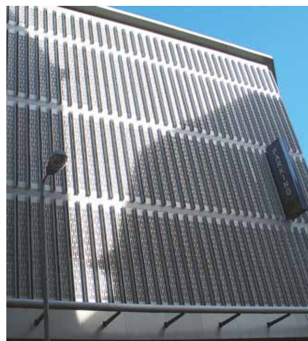
Irlanda: tamponamento verticale di un parcheggio multi piano realizzato in lamiere forate in acciaio inox Ireland: vertical stainless steel cladding panels in a multi storey car parking
