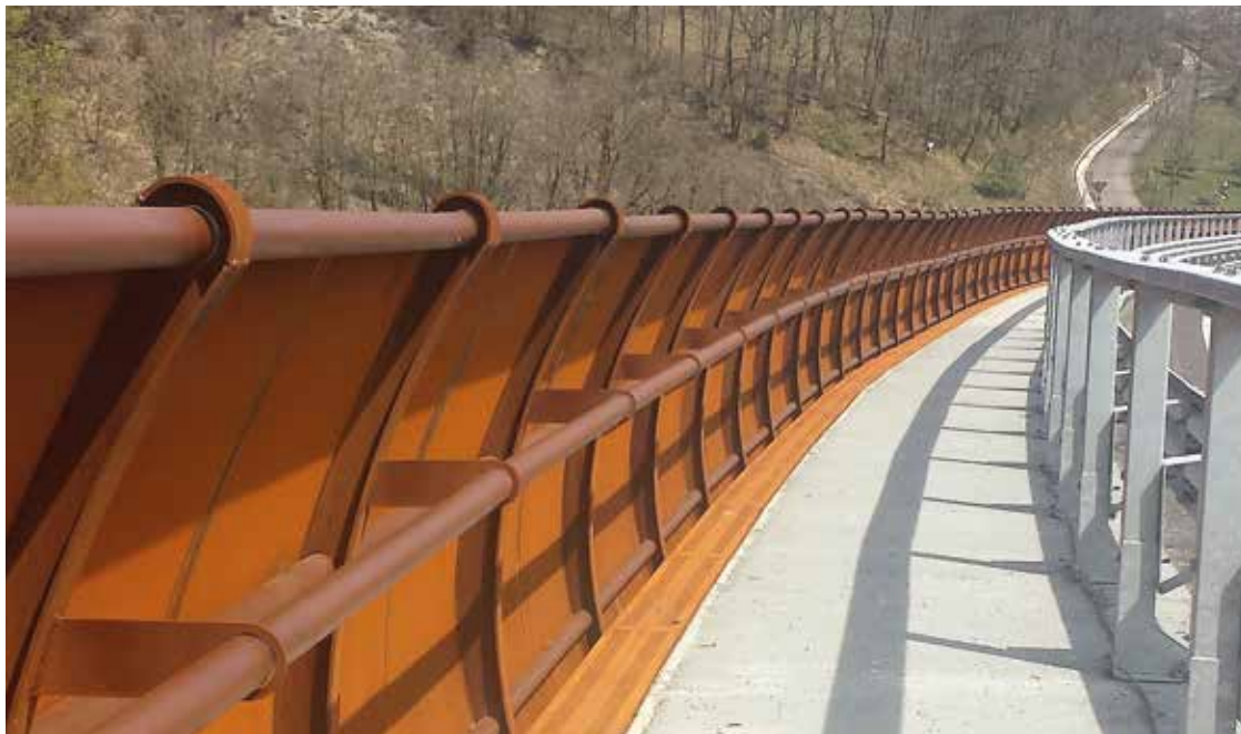
Reggio Emilia: parapetto in Corten forato e calandrato per un viadotto.
