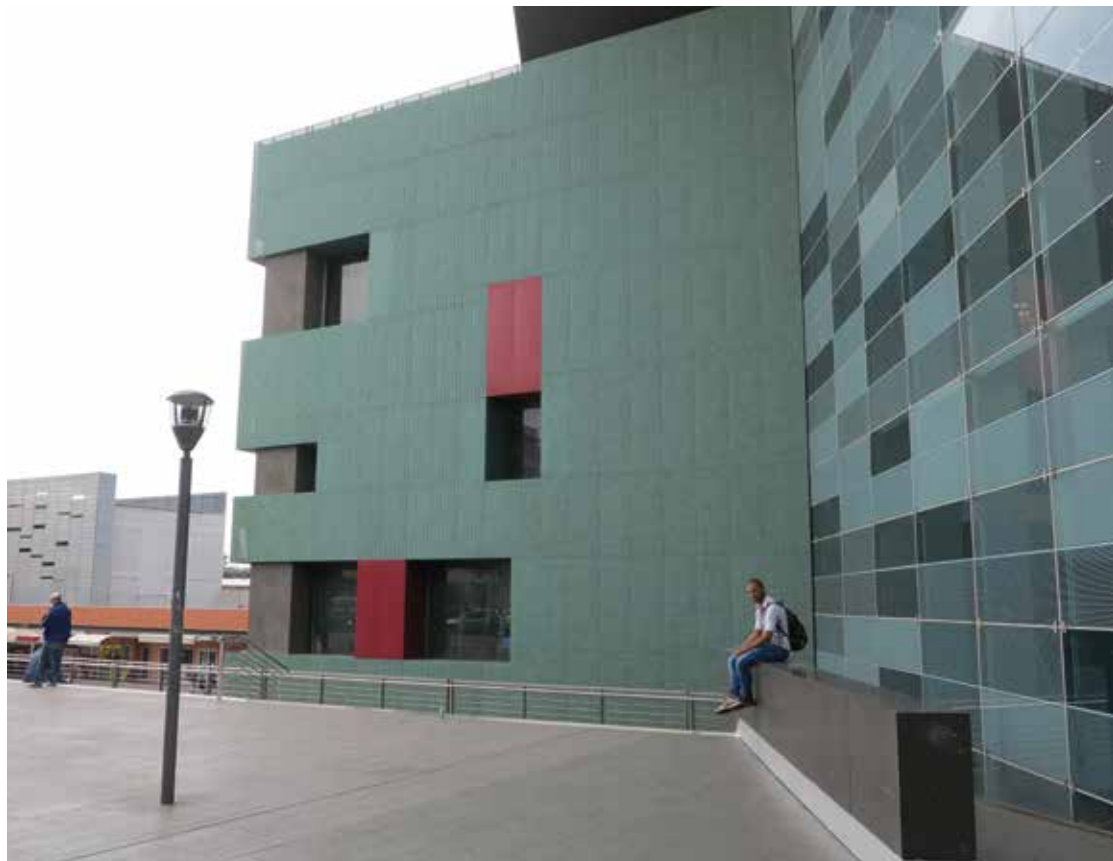
Mirandola (MO): rivestimenti di facciata in alluminio forato e anodizzato: particolari ad angolo.
