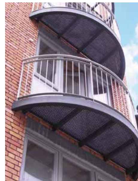
Irlanda: balconata con pavimentazione in lamiera forata di alto spessore verniciata a polveri Ireland: balcony flooring made of thick perforated and painted aluminium
